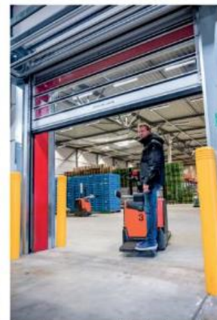
De turbodeur van Efaflex, opent in 3 meter per seconde
