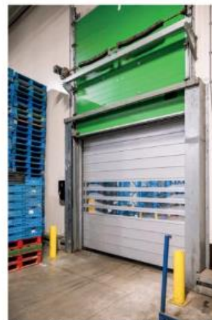
Het verschil met de oude deur, de deuren van Efaflex belasten de vering niet dankzij de spiraalrol
